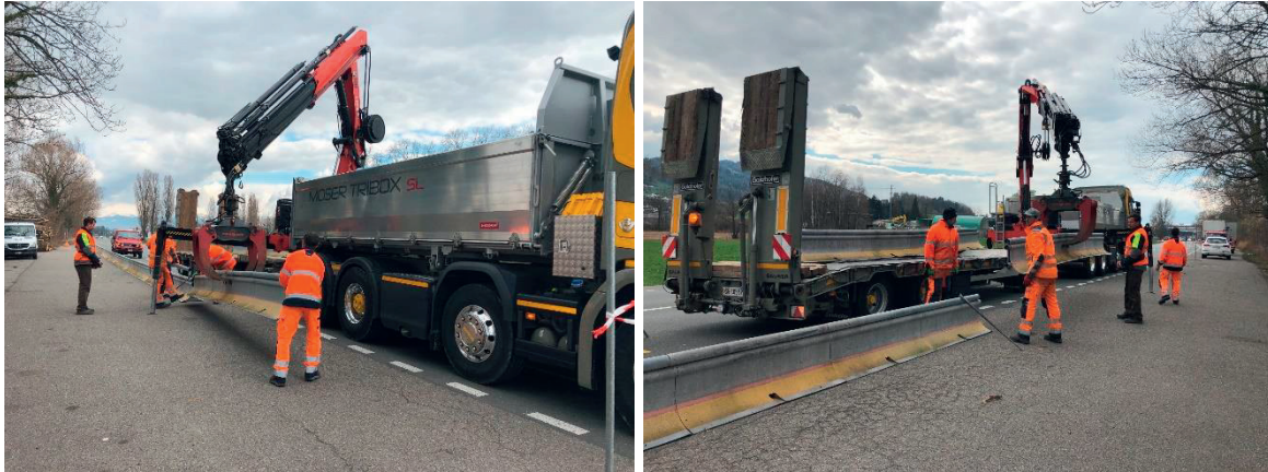
Abschrankungsarbeiten entlang der Burietstrasse
